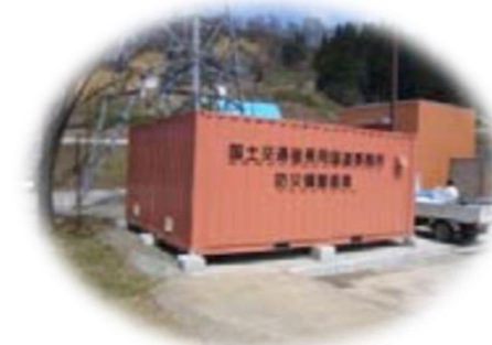
防災倉庫 【出典：国土交通省 HP】
