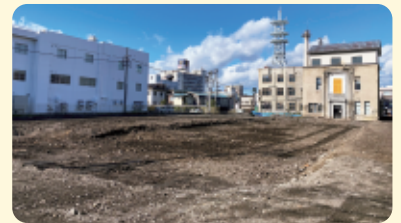
本庁舎新館外解体後の敷地状況 (令和4年10月時点)
